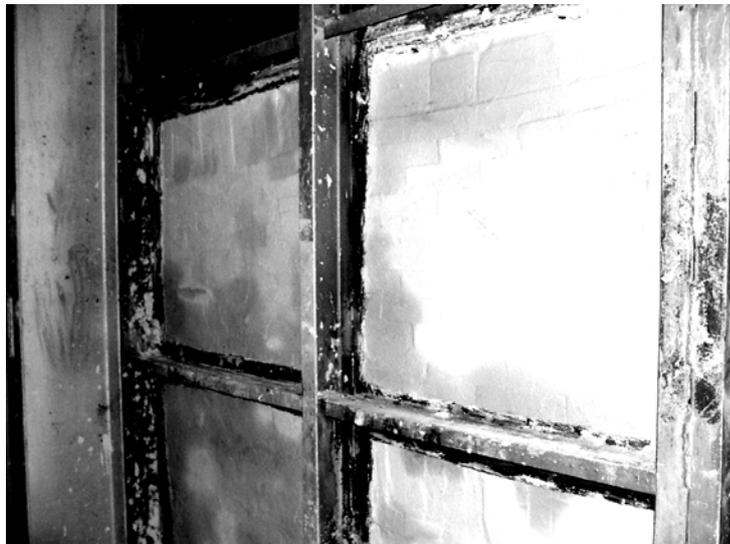
Рисунок 1 – Монтаж обмуровки котлоагрегата Сургутской ГРЭС-1
